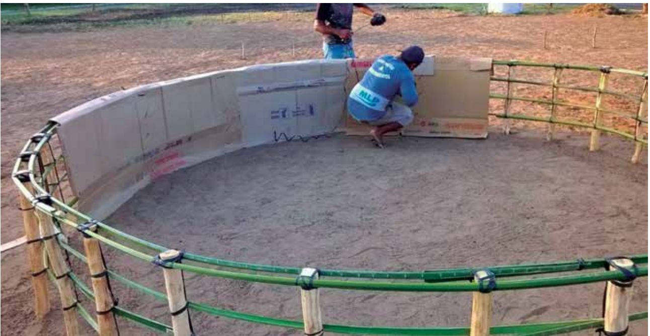
Modelo de revestimento com papelão.
