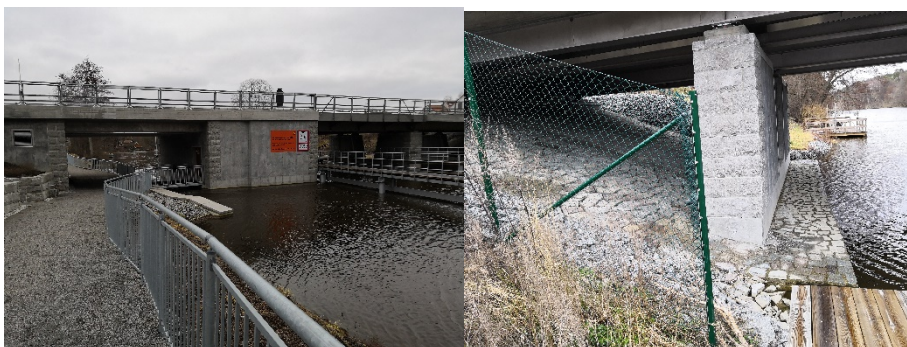
Figur 5 a+b. Flottsundsbrons a vänstra passage, b högra passage.
