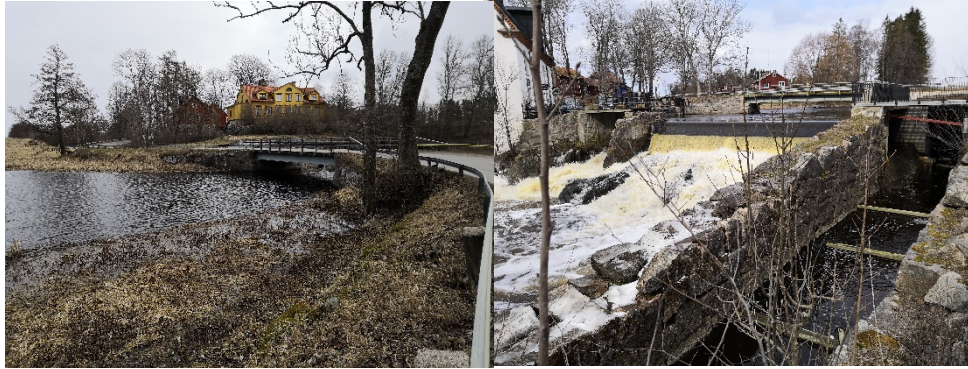
Figur 23a+b. Ulva kvarns bro a uppströms och b nedströms
