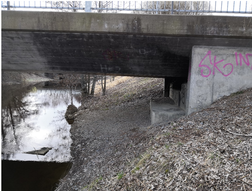
Figur 21. Bärbysspångens högra passage
