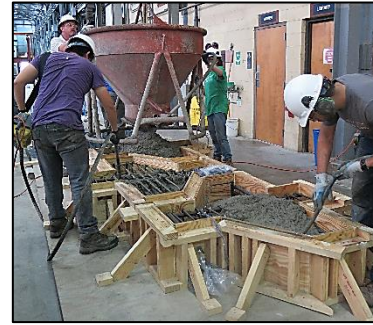
(d) Internal Vibration
