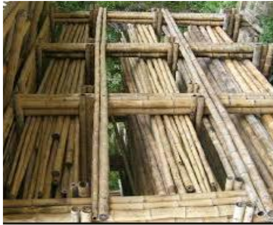
Figura 96. Juntas de vigas y columnas en bambú en donde permanece la continuidad de las vigas.
