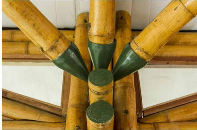
Figura 94. Conexiones en bambú bajo el criterio de Vélez. Biblioteca de la Facultad de Arquitectura de la Universidad Católica Santiago de Guayaquil.
