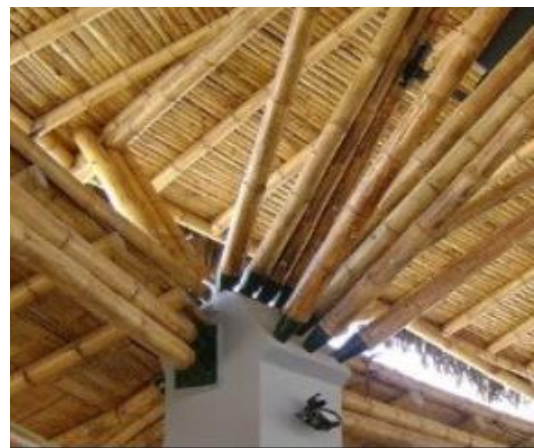
Figura 92. Conexiones en bambú bajo el criterio de Vélez.
