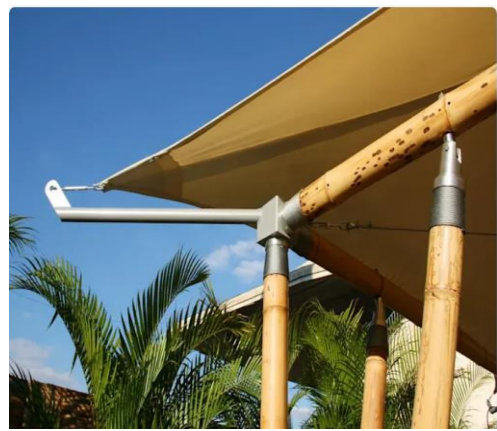
Figura 92. Conexiones en bambú bajo el criterio de Vélez.
