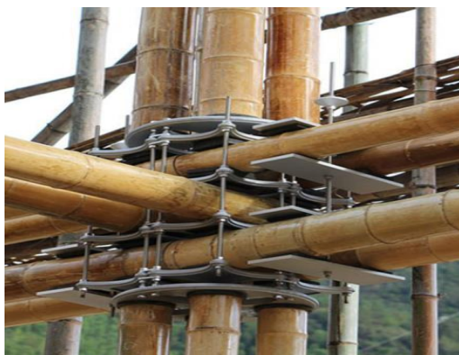
Figura 100. Conexiones a momento con placas de acero.
