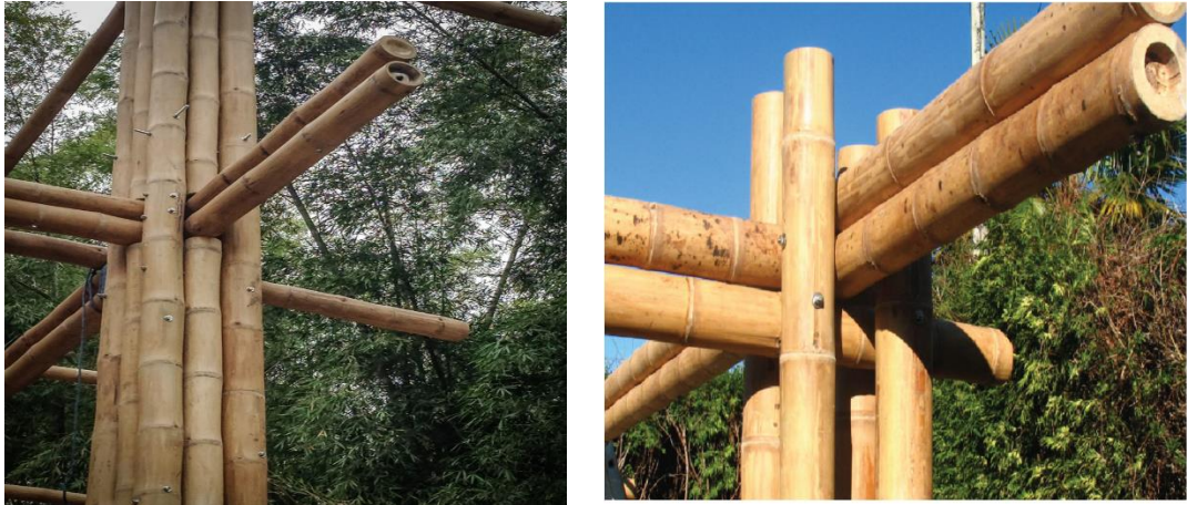
Figura 96. Juntas de vigas y columnas en bambú en donde permanece la continuidad de las vigas.
