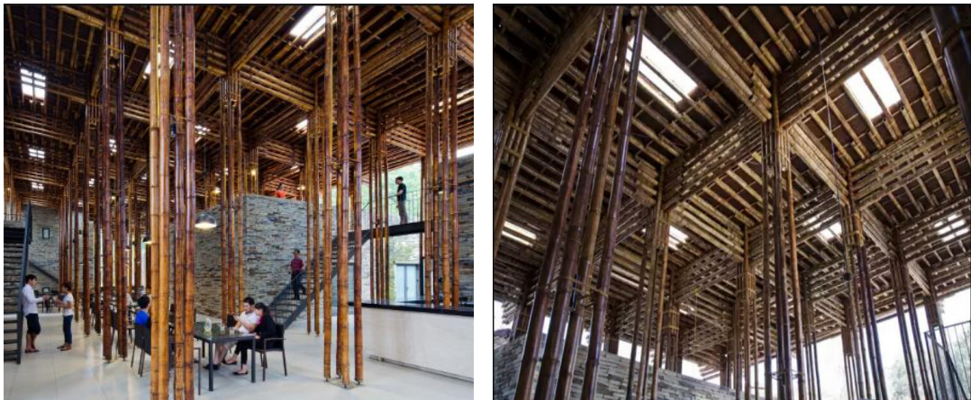
Figura 95. Juntas de vigas y columnas en bambú en donde permanece la continuidad de las vigas. Restaurante en Panamá.
