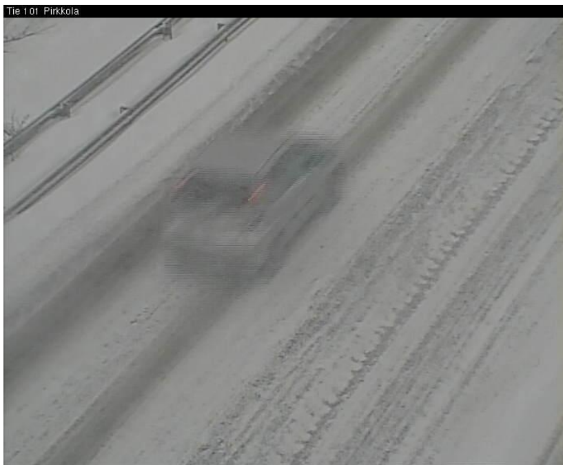
Kuva 4.4: Polannetta havaittavissa tienpinnalla tiellä 101 eli Kehä I:llä Helsingin Pirkkolassa 1. helmikuuta klo 13.43. Polanne havaitaan helposti tien tummasta asfalttipinnasta tien oikeanpuoleisella kaistalla poikittaisena säännöllisinä valkoisina raitoina.
