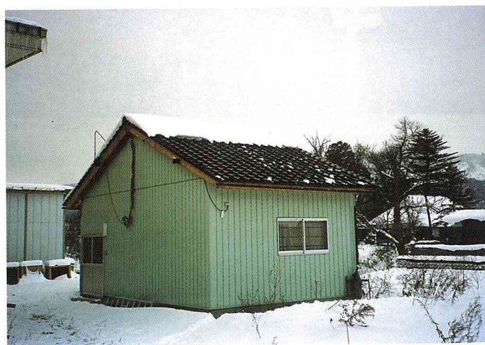
図1.2.5 融雪実験状況（山形大学工学部：米沢市）
