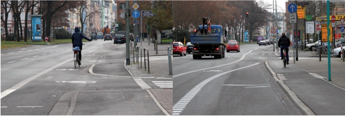
Abbildung 1 Duale Lösung an der Rotschildallee in Frankfurt (eigene Aufnahme vom 05.09.2018)
