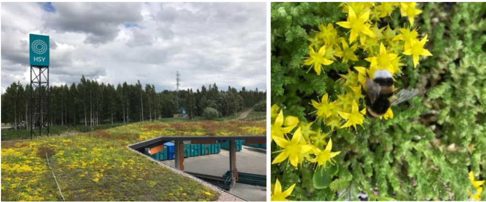
Kuva 2. Viherkatto. Sortti-aseman katolla kasvaa maksaruohojen lisäksi kuivuutta sietäviä niittykasveja. (Kuvat Taina Suonio.)
