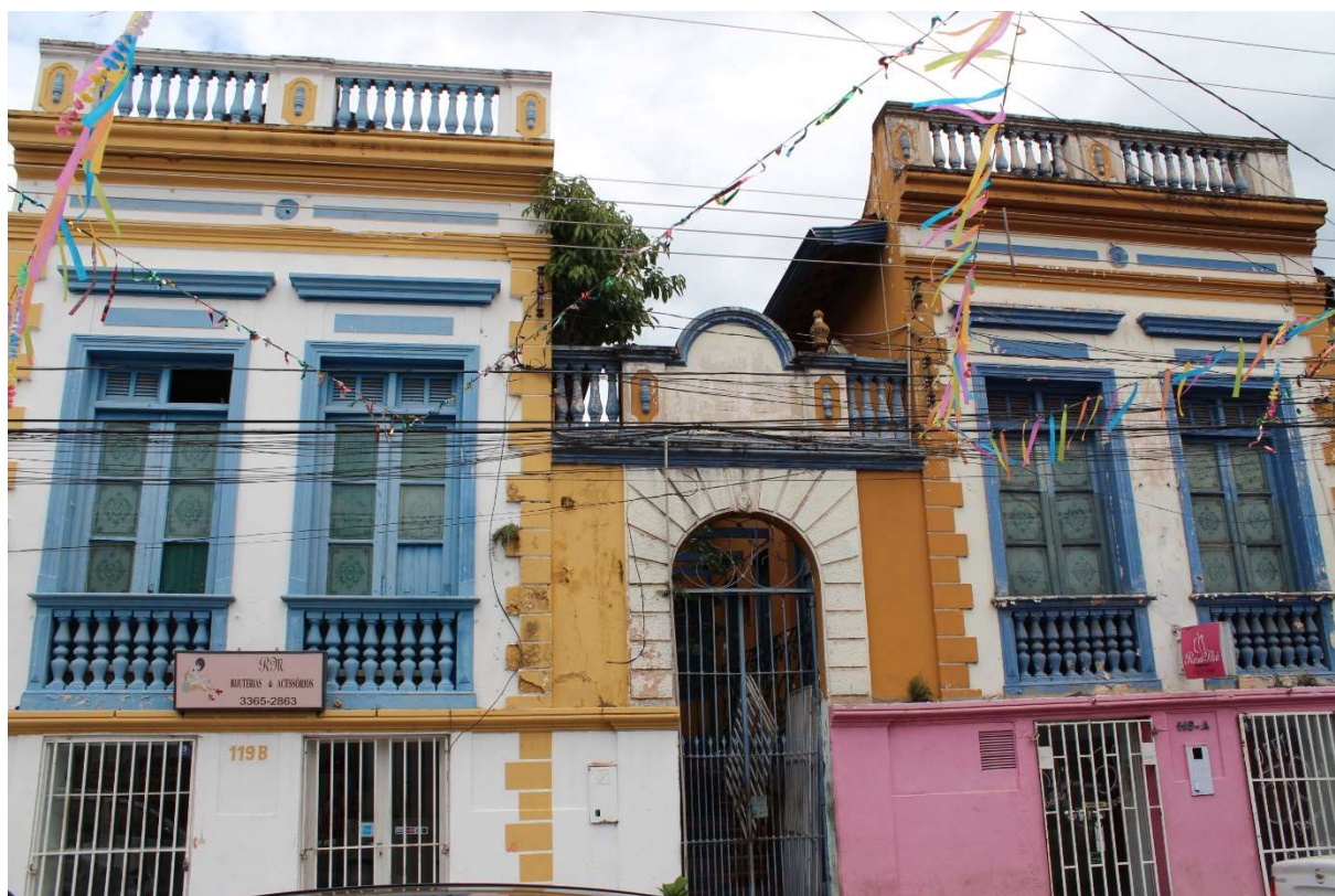
Foto 6- Imóvel localizado na Rua Pedro Celestino, Centro, em Cuiabá/MT. - foto Amilton Martins
