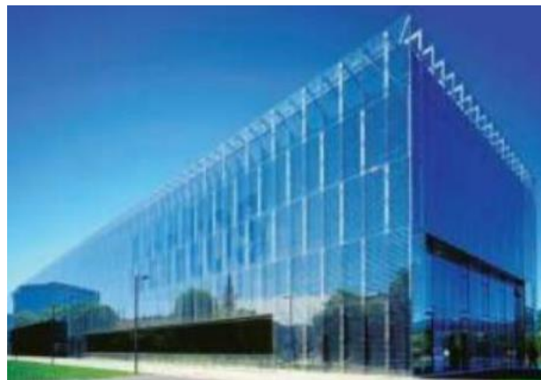
Gambar 28 Aplikasi kaca pada penutup dinding bangunan (Sumber : Wurm, 2007)
