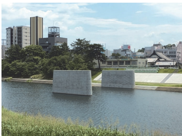
図5 建設中の人道橋 (2017年7月18日、筆者撮影)
