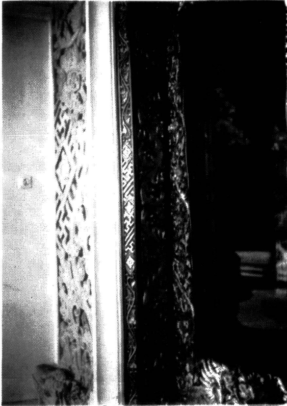
18. Hiasan ukiran di pinggir pintu Wisma Merdeka.
