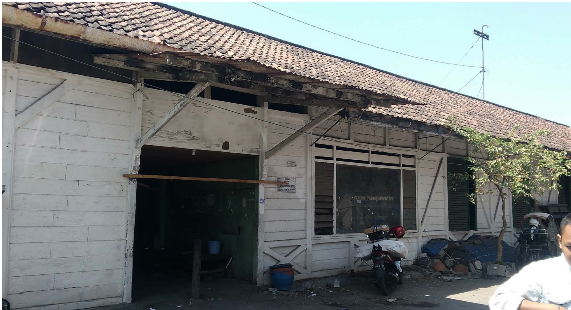
Foto 17. Fasad Stasiun Lama Gresik (Sumber: Putranto)
