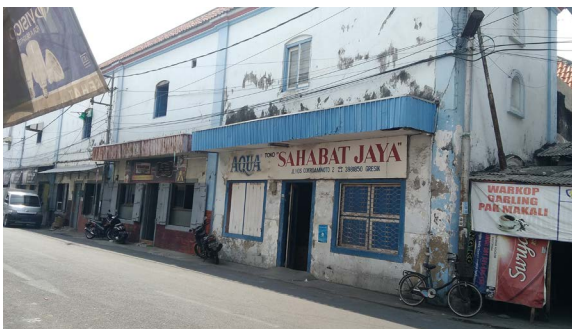
Foto 6. Fasad Depot Hidayah (Sumber: Putranto)
