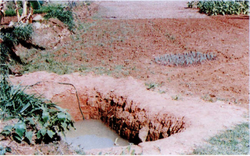
Foto 4.3. Gumuk, sumur galian yang ada di sawah
