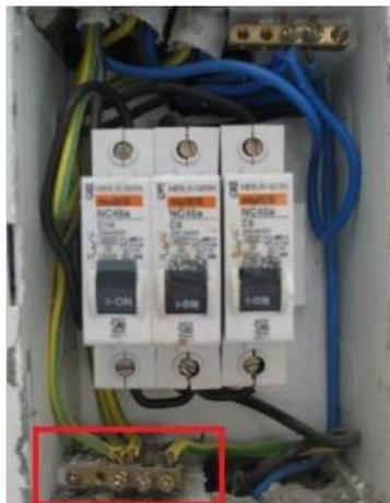
Gambar 6. Terminal pentanahan dalam kotak MCB
