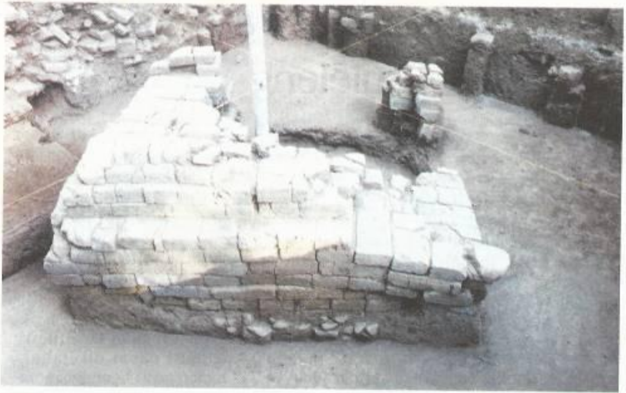
Pondasi Bangunan (Stupa) di situs Kalibukbuk, Buleleng
