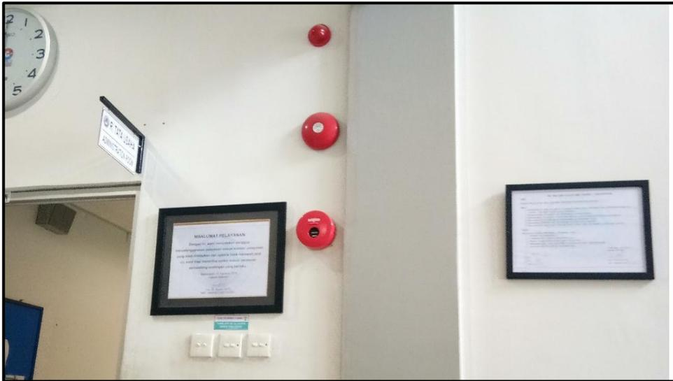
Gambar 3.18. Sistem alarm gedung
