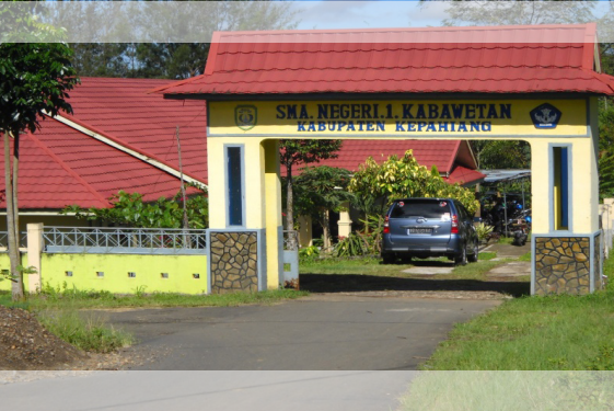
Gambar 28: Gedung SMA di Kelurahan Tangsi Baru (Dokumentasi:Tim)
