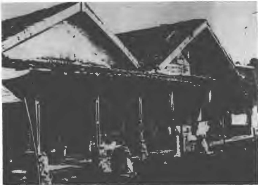
Gambar 2 Bangunan rumah panjang di pinggir sungai
