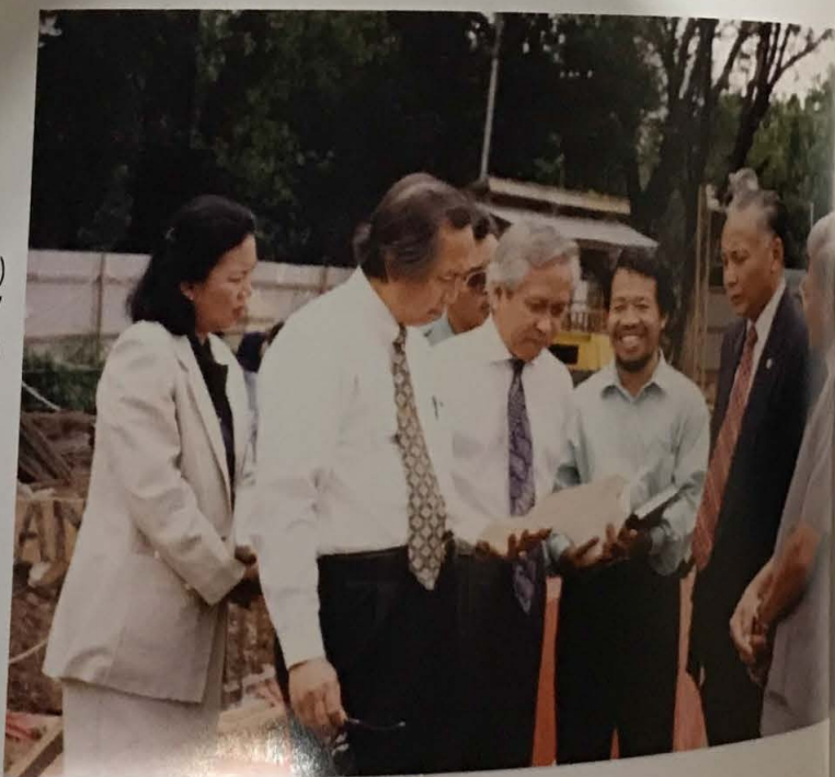
FOTO WARDIMAN DJOJONEGORO (KE-2 SEBELAH KANAN) MEMANTAU PEMBANGUNAN GEDUNG B, 1997 Koleksi Museum Nasional Indonesia
