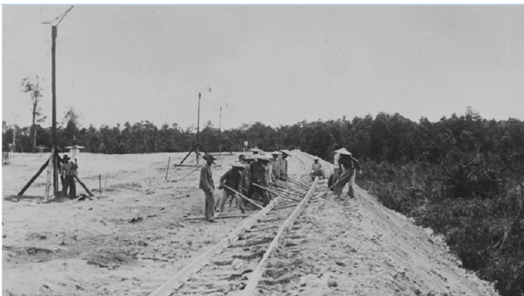
Gambar 8. Foto koelie tambang memperbaiki rel kereta Decauville di Sungailiat (Sumber: Tropen Museum 1914 )
