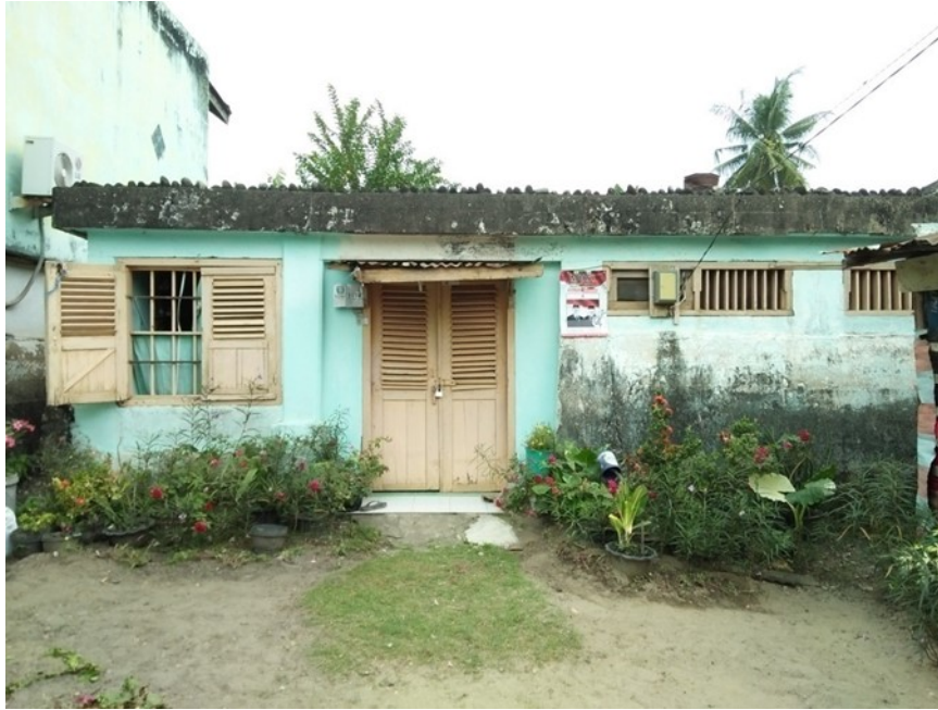
Gambar 6. Bunker Lorong Sikam tampak depan (Sumber: Dok. penulis)
