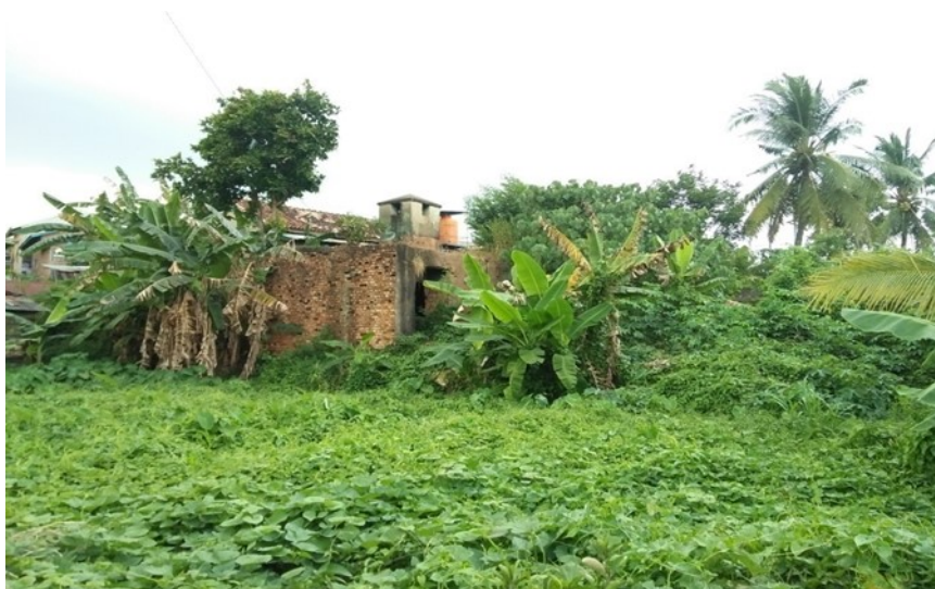
Gambar 2. Tampak samping bunker di Jalan Akbp Umar (Sumber: Dok. Penulis)
