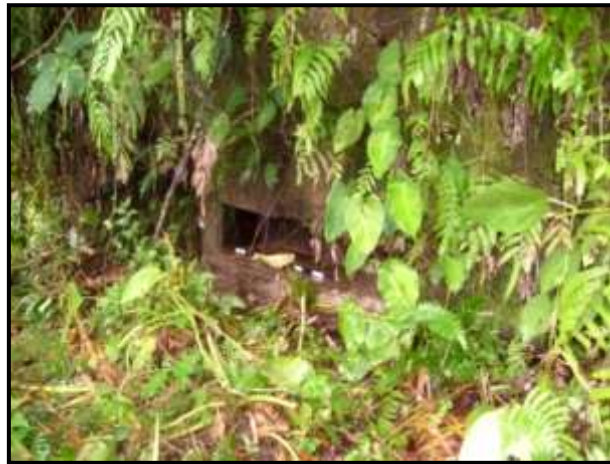
Gambar 6. Gambaran lokasi pahatan relung-relung di Tunggung Batu yang ditumbuhi semak belukar. Saat hujan kondisi bagian dalam objek tergenang air hujan (dokumentasi BP3 Banda Aceh, 2008)
