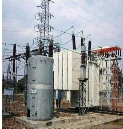
Gambar 7.8. Resistor Jenis 250 (Sumber: BSE Jaringan Transmisi Tenaga Listrik)
