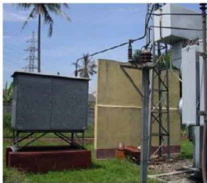
Gambar 7.7. Resistor Jenis Logam (metallic resistor) (Sumber: BSE Jaringan Transmisi Tenaga Listrik)
