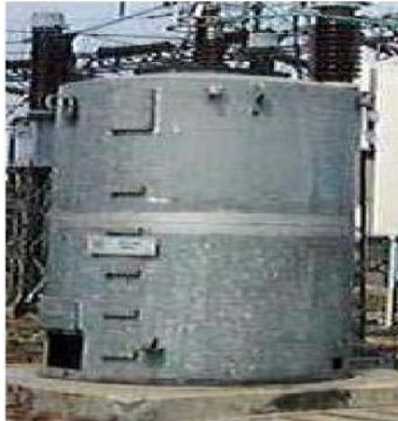
Gambar 7.9. Resistor Jenis Cairan (liquid resistor) (Sumber: BSE Jaringan Transmisi Tenaga Listrik)
