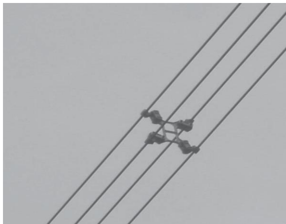
Gambar 14. Spacer untuk konduktor berkas 4 kawat ( quadruple )
