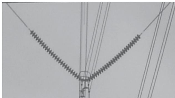
Gambar 7. Isolator renceng untuk tower tension SUTETI ("V" type)
