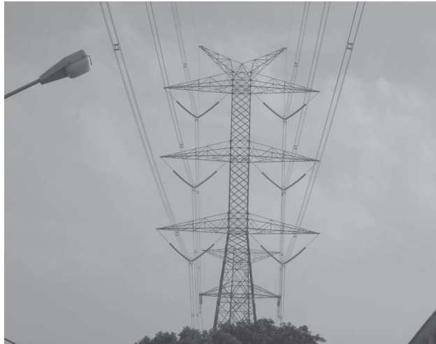
Gambar 8. Konfigurasi Isolator tower Suspensi SUTET 500 kV
