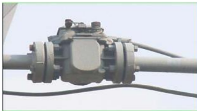
Gambar 3.22 Bentuk Fisik dari Relai Bucholtz
