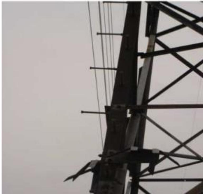
Gambar 17. Baut Panjang (Step Bolt)
