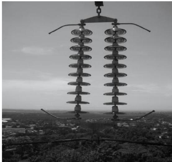
Gambar 29. Pemasangan isolator piring pada saluran
