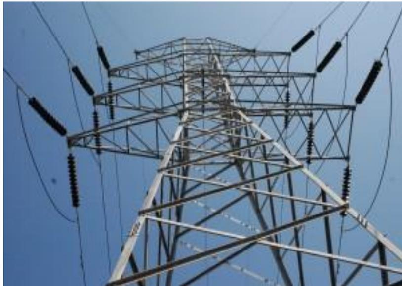
Gambar 24. Tower/menara saluran udara tegangan tinggi (SUTT)
