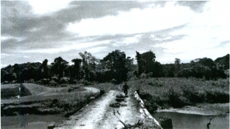
Gambar 12. Jembatan Kayu yang menghubungkan Sausapor –Werur Sumber : Tim Sausapo BPNB Jayapura
