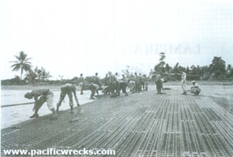
Para pekerja yang sedang mengerjakan lapangan terbang dengan menyusun tikar baja sebagai landasan pesawat terbang.
