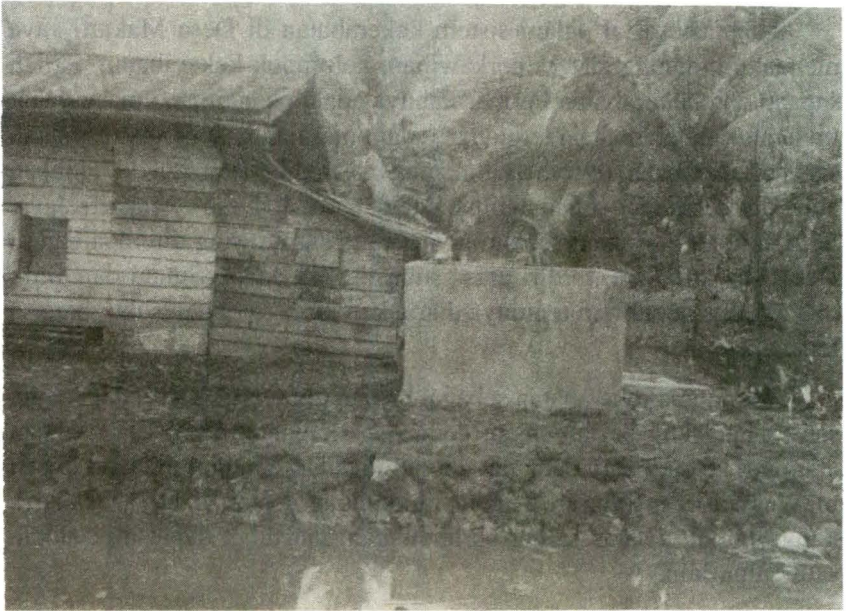
Gambar 26 Bak penampungan air hujan
