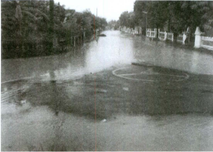
Foto 4. 1. Kondisi Setelah Banjir di Desa Pilang
