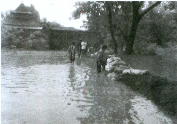
Foto 4.8. Kerja Bakti Memperbaiki Tanggul yang Rusak Akibat Banjir.
