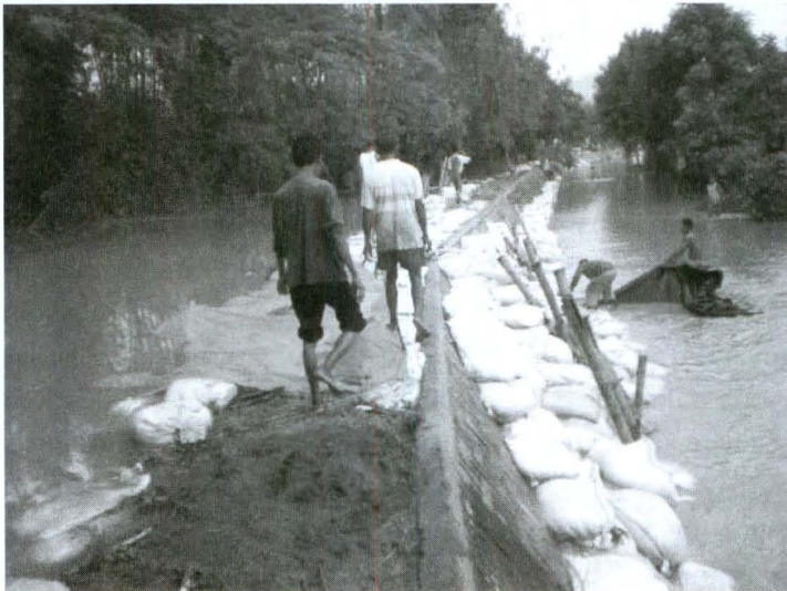
Foto 3.6. Lahan Bantaran dan Pembangunan tanggul
