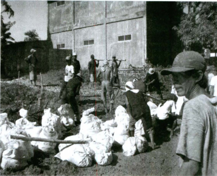
Foto 4.16. Gotong Royong Tinggikan Tanggul Jalan di Semabung
