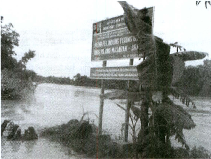
Foto 4.4. Jalan Rusak Akibat Banjir di Pilang
