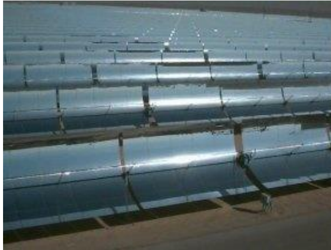
Gambar 18. Parabolic Troughs adalah salah satu alat pengumpul panas ( collector ) yang digunakan pada pembangkit listrik tenaga surya yang berada di the Mojave Desert at Kramer Junction, California .
