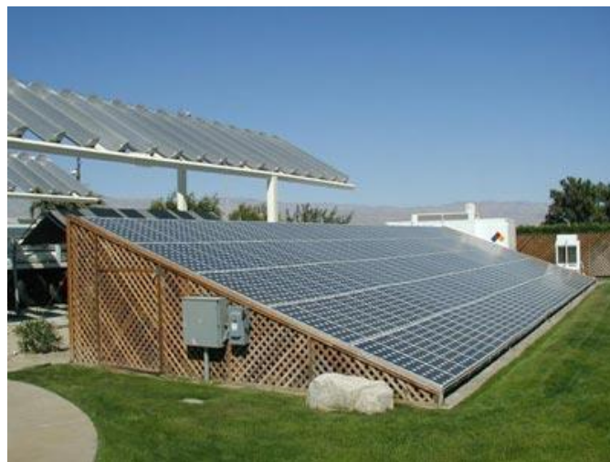
Gambar 17. Sel surya ( photovoltaic or solar cell ), alat untuk mengubah energi matahari menjadi energi listrik
