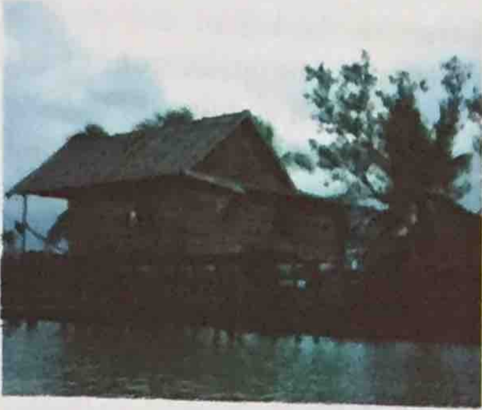
Gambar 4.6. Rumah panggung di atas air dengan menggunakan tiang kayu nibung, Simpang PU, Kab. Banyuasin
