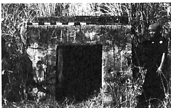
Gambar 5: Lofra di Bandara Koabang, Kao
