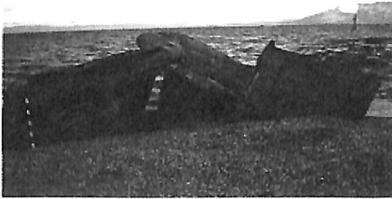
Gambar 1: Lofra/pillbox yang hancur akibat abrasi air Laut di Desa Kusu, Kec. Kao
