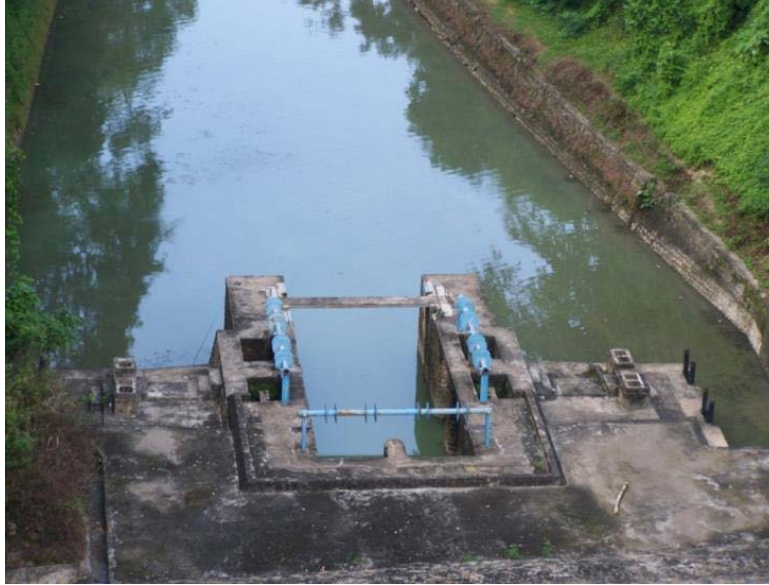
Foto 5. Pintu outlet tampak dari atas
