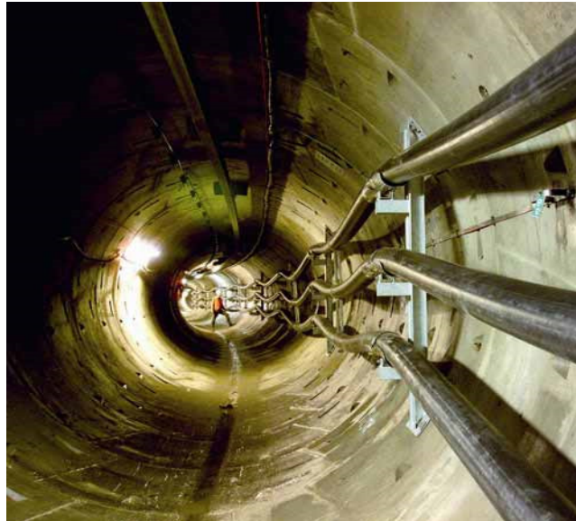
Gambar 40. Saluran kabel bawah tanah
