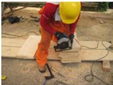
Gambar 4.35 Penakikan Komponen Papan Anak Tangga
