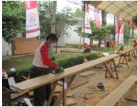
Gambar 4.34. Pengetaman Komponen Papan Ibu Tangga
