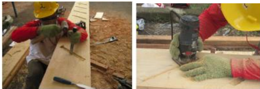
Gambar 3.40. Proses Pembuatan Lobang Papan Langkah
