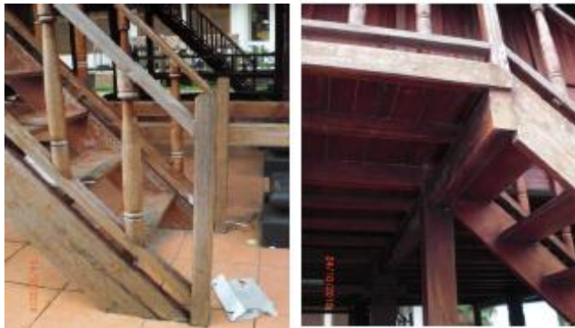
Gambar 4.41. Tumpuan Tangga Bawah dengan Balustrade dan Tumpuan Atas
