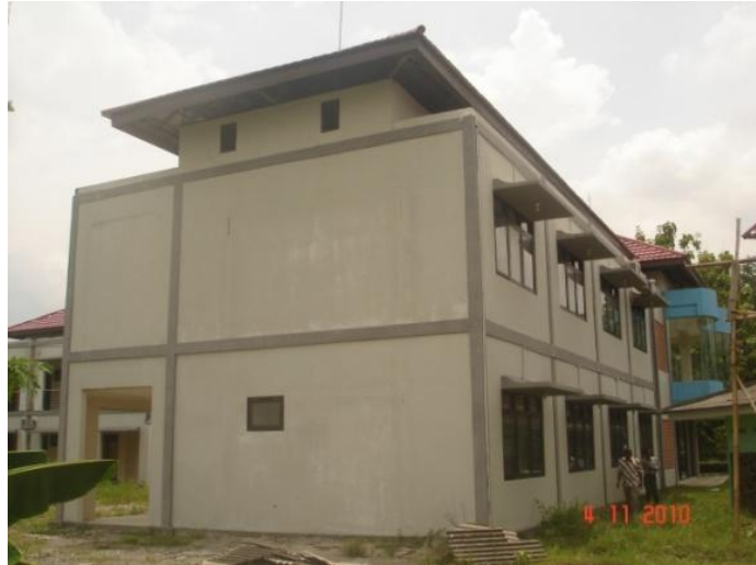
Gambar 3.19. Gedung Asrama Balai Irigasi di Solo Menggunakan Dinding n-Panel Sistem(Sumber: Puslitbang Permukiman, 2010)
