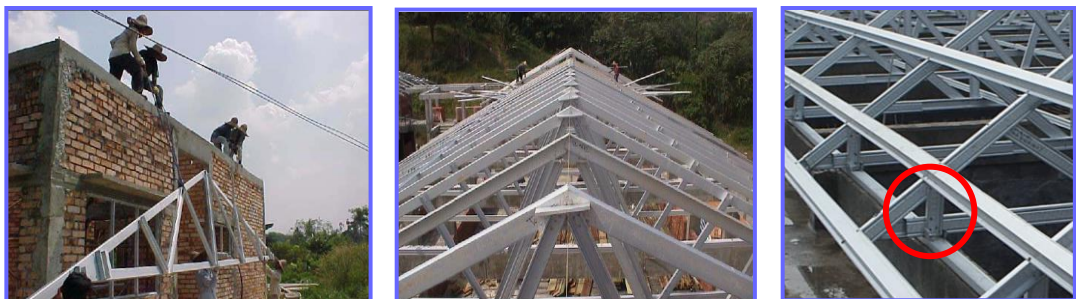
Gambar 1.39. Proses Pengangkatan dan Penyusunan Kuda-kuda Sumber : Dokumentasi PT. Fenejo Mitra Prima, 2015
