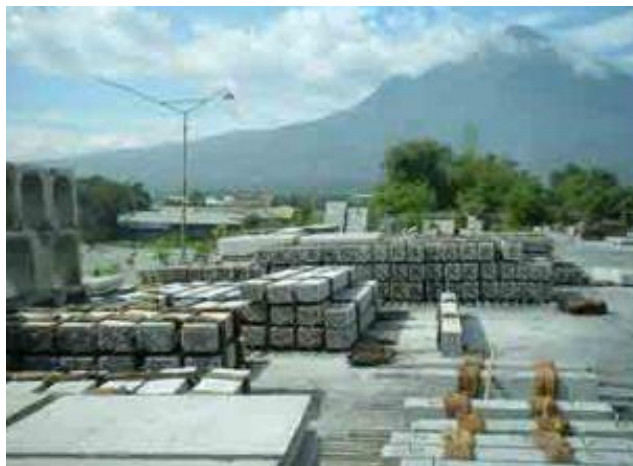
Gambar 3.10. Handling dan Storage
