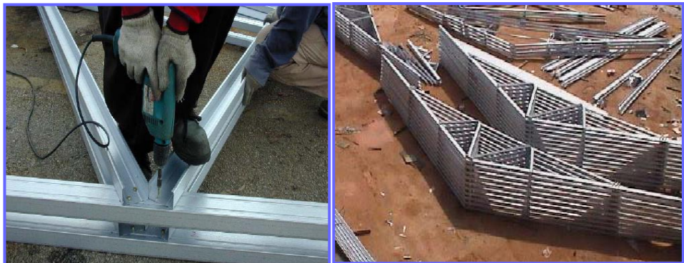
Gambar 1.37. Perakitan Baja Menjadi Kuda-kuda Sumber : Dokumentasi PT. Fenejo Mitra Prima, 2015
