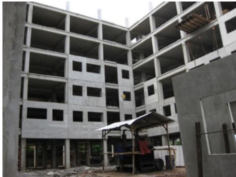
Gambar 3.20. Pembangunan Apartemen di Jakarta Menggunakan Panel Dinding Pracetak (Sumber: Nurjannah, 2009)
