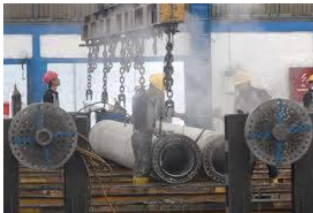
Gambar 3.9. Curing beton pracetak.
