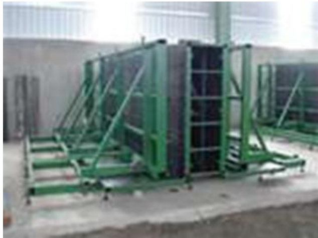
Gambar 3.4. Persiapan cetakan untuk beton pracetak
