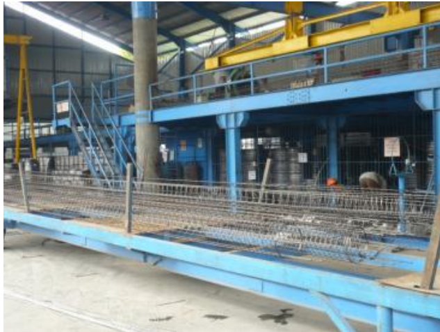
Gambar 3.6. Tulangan yang telah dirakit ditempatkan kedalam cetakan.
