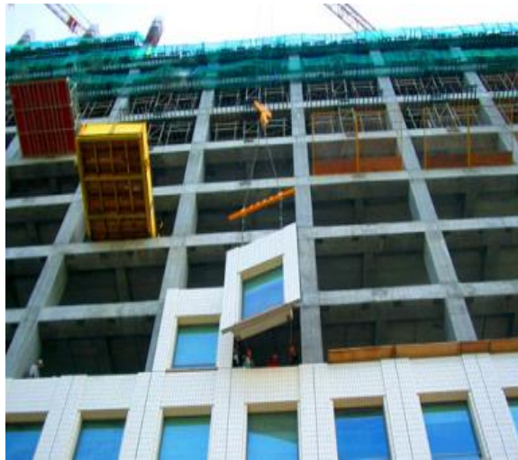
Gambar 3.2. Pengangkutan dan Pemasangan Dinding Luar Pracetak
