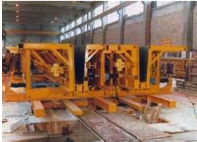
Gambar 3.8. Pematatan beton pracetak.
