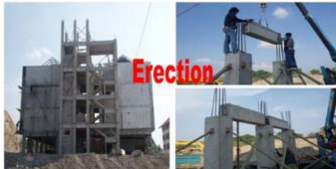
Gambar 3.21. Bangunan Asrama Universitas Diponegoro Menggunakan Sistem Join Balok Kolom L-10 dari PT Tribina Prima Lestari (Sumber: Lestari, P.T., 2007)
