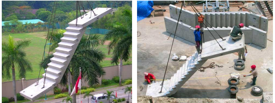
Gambar 3.3. Tangga precast saat di angkat ke lokasi pemasangan.
