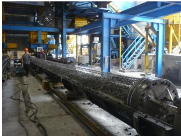
Gambar 3.7. Pengecoran beton pracetak.
