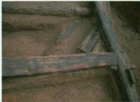
Gambar 3.5 Teknik konstruksi tiang bangunan Uma ceko (siku).
