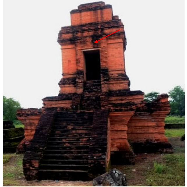
Gambar 2. Cor beton pada atap pintu masuk candi Sipamutung
