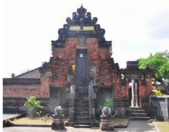
Foto 2. Gapura paduraksa menuju halaman jeroan (Sumber: Puslit Arkenas 2013)
