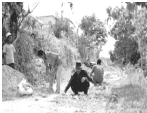
Foto 1: Royongan membuat jalan dusun
