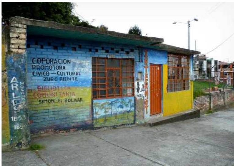
Imagen 30. Biblioteca Pública Comunitaria Simón el Bolívar antes de la intervención. Fotos de Arquitectura Expandida, 2012.
