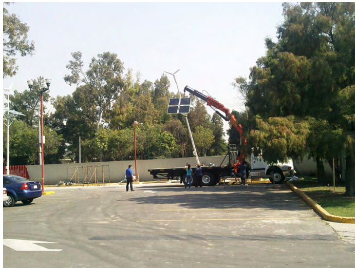
Figura 77. Ejemplo de izamiento con grúa en la UAM Azcapotzalco.
