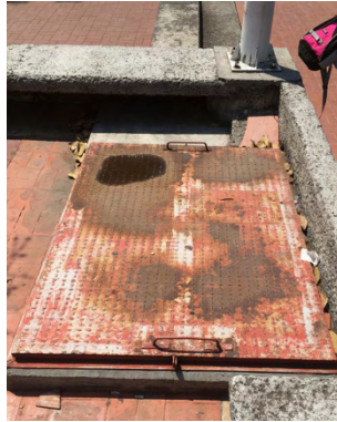
Figura 13. Registro de concreto para albergar las baterías de luminarias UAM Azc.
