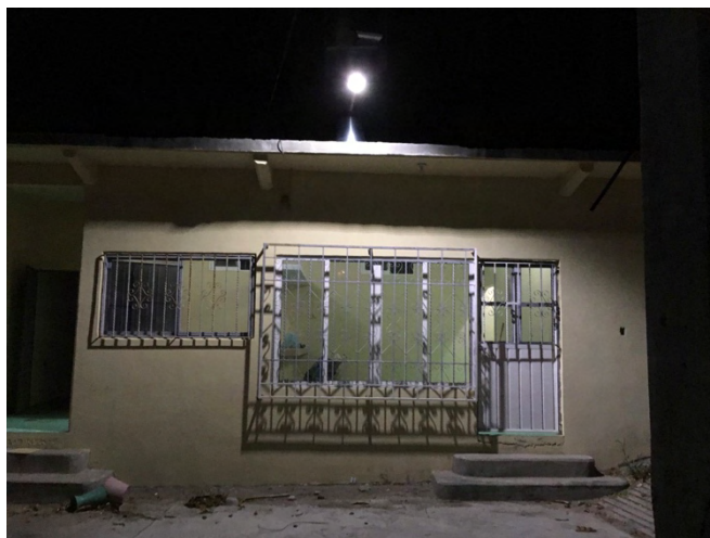
Figura 68. Luminaria instalada en una casa de Tehuantepec.
