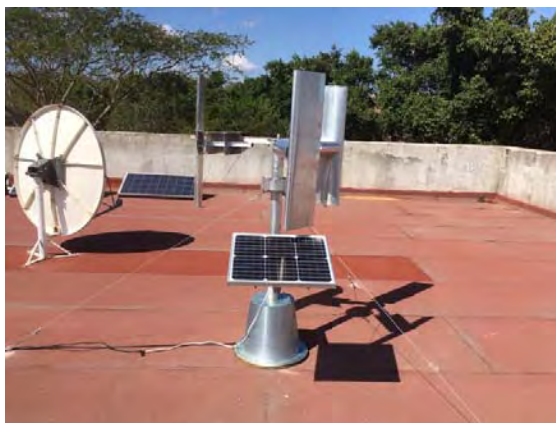
Figura 63. Luminaria eólico-solar colocada en el techo del laboratorio de ciencias de la energía eólica con el diámetro del rotor original (1.15m).
