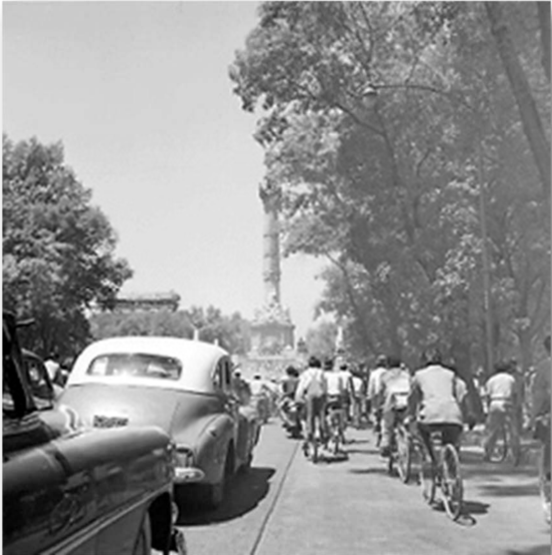
Imagen 23. Transporte público y movilidad urbana sobre Reforma 1957
