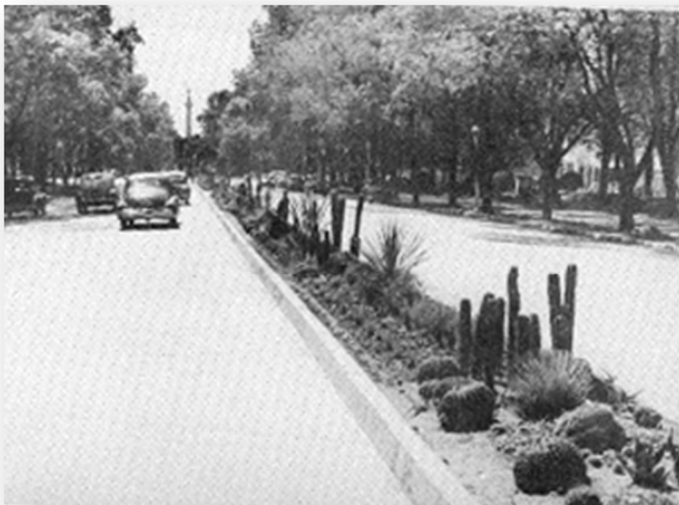
Imagen 25. Transformación del Paseo de la Reforma 1940 a 1980
