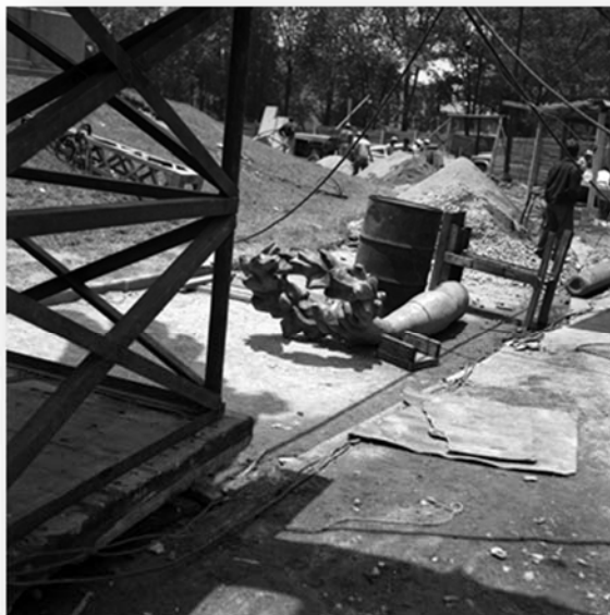
Imagen 24. Sismo de 1957 que afectaron la estructura de la columna y derribaron la escultura del Ángel de la Independencia
