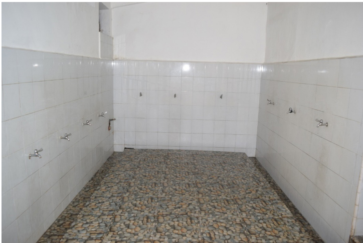
Gambar 65. Tempat Wudhu Masjid Raya Sultan Sulaimaniyah, Perbaungan
