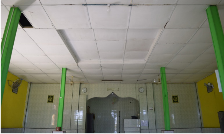
Gambar 17. Keempat Tiang Sokoguru Utama Masjid Jami' Sultan Sinar Sumber: Dokumentasi Tim Penulis
