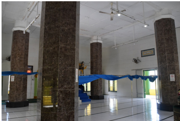
Gambar 36. Balok Anak Tiang Sokoguru Yang Sebagian Sudah Tertutup Asbes Masjid Raya Sultan Basyaruddin, Desa Rantau Panjang Sumber: Dokumentasi Tim Penulis
