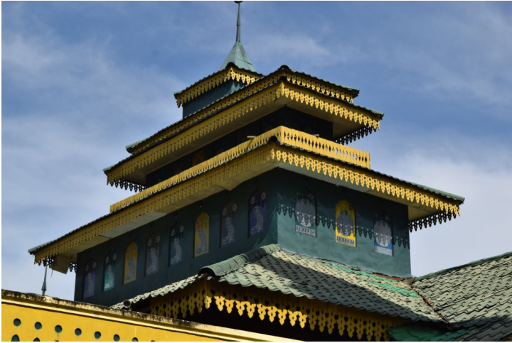
Gambar 56. Atap Masjid Raya Sultan Sulaimaniyah, Perbaungan
