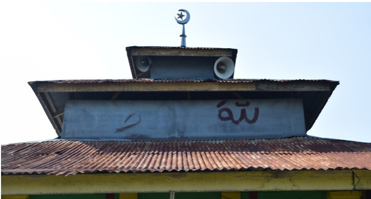
Gambar 18. Atap Masjid Jami' Sultan Sinar Sumber: Dokumentasi Tim Penulis
