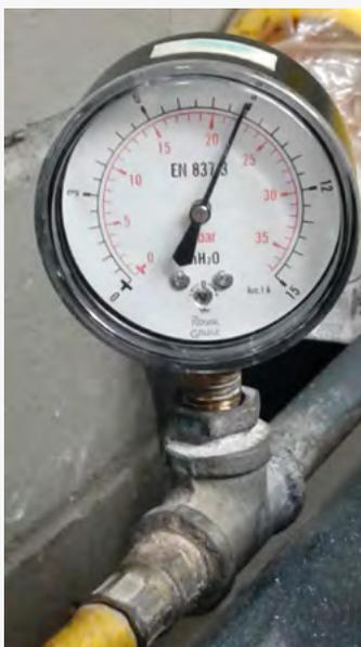
**Figura 2.3.** Manómetro de baja presión de 0 a 50 mbar.
