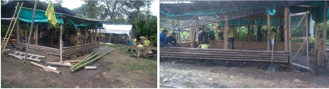
Figura 18: Adecuación de instalaciones. Tomada por el autor
