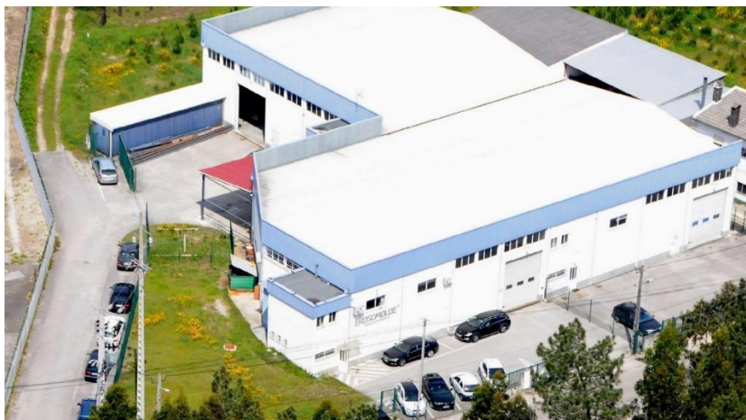
Figura 12 - Instalações Erosomolde, Lda.
