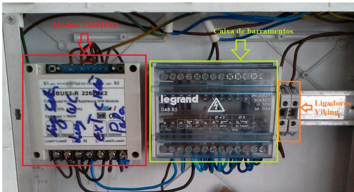
Figura 6.39 - Quadro domótica do 2.º andar em fase de acabamentos.
