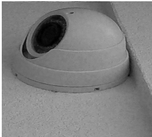
Figura 4.8 - Câmara dome instalada.
