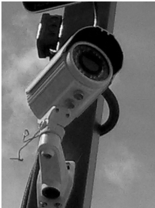
Figura 4.9 - Câmara tubular instalada.
