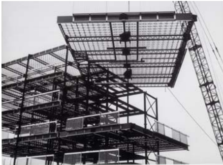
7. Marcel Lods, essai de prototype du GEAI, en vue de la construction de la cité de la Grand-Mare à Rouen.
