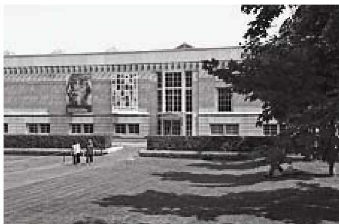
14. Centre canadien d'architecture, parc Baile, par l'architecte Peter Rose.
